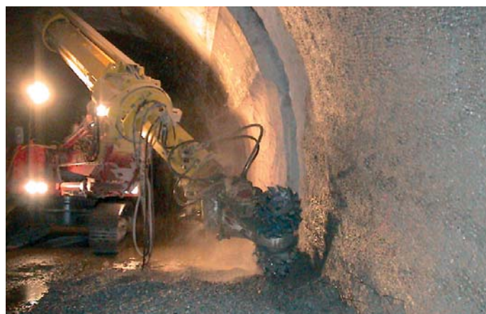
Dieser Tunnelleinsatz zeigt die „ER 1500 T“ an einem 35t-Teleskopbagger.
