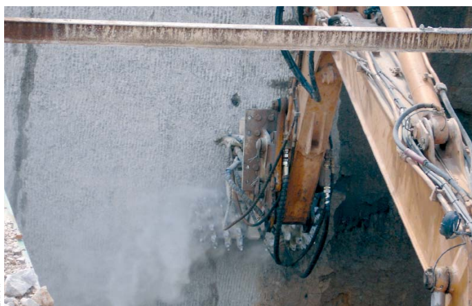
Bei einem Einsatz in Spanien fräst diese „ER 650 P“ Baugrubenwände exakt, sauber und gerade.
